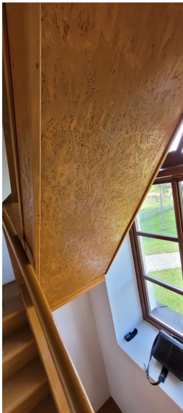
Foto. 3, 4. Zabudowa schodów z płyty wiórowej
